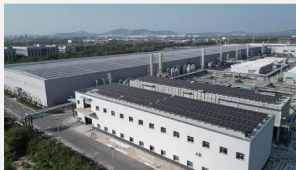
徐州贾汪新型电力系统 10MW光伏+10/20MW储能项目
